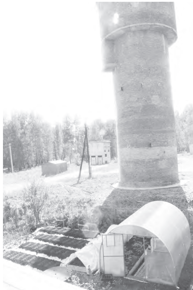
Водонапорная башня и огороды жителей соседствуют рядом
