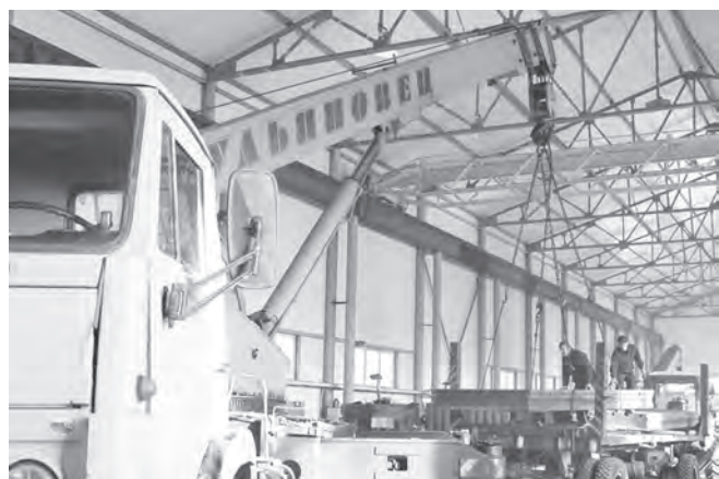
Рабочие цеха транспортируют с помощью автокрана тяжёлые металлические платформы
